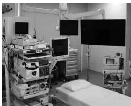
④ 5階内視鏡治療室シーリングシステム
