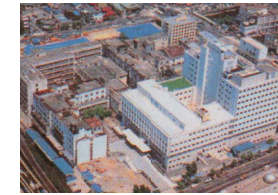
外来診療棟竣工(昭和53年)
