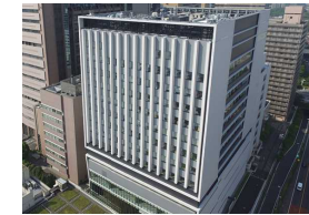
研究棟新棟竣工(2017年)
