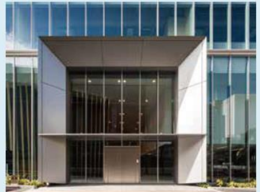
北東側エントランス
