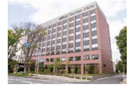
三井ガーデンホテル柏の葉パークサイド竣工（2022年）
