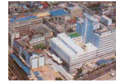
外来診療棟竣工（昭和53年）
