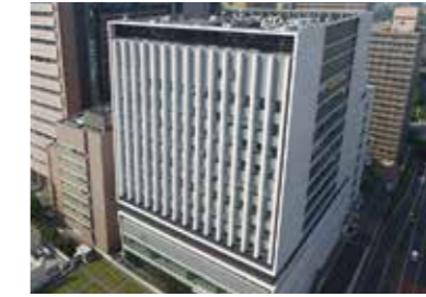
研究棟新棟竣工（2017年）
