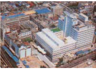
外来診療棟竣工（昭和53年）
