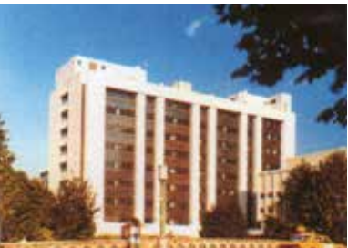
研究棟竣工（1981年）
