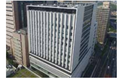
研究棟新棟竣工(2017年)
