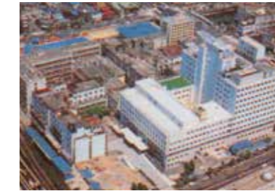
外来診療棟竣工(昭和53年)
