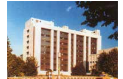
研究棟竣工(昭和56年)
