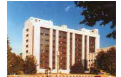
研究棟竣工(昭和56年)
