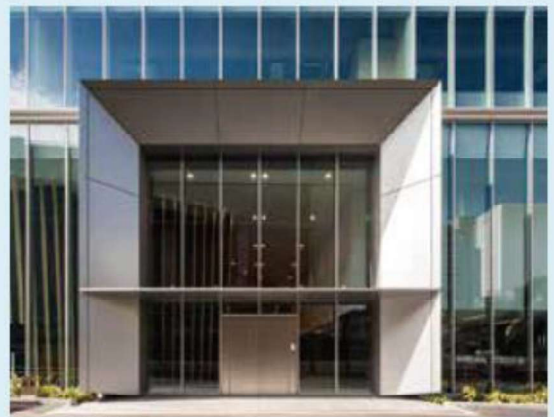
北東側エントランス
