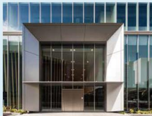
北東側エントランス
