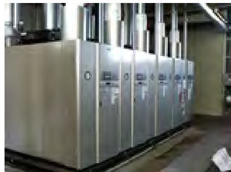
吸収式冷凍機(蒸気を利用して冷水を発生)×3台
